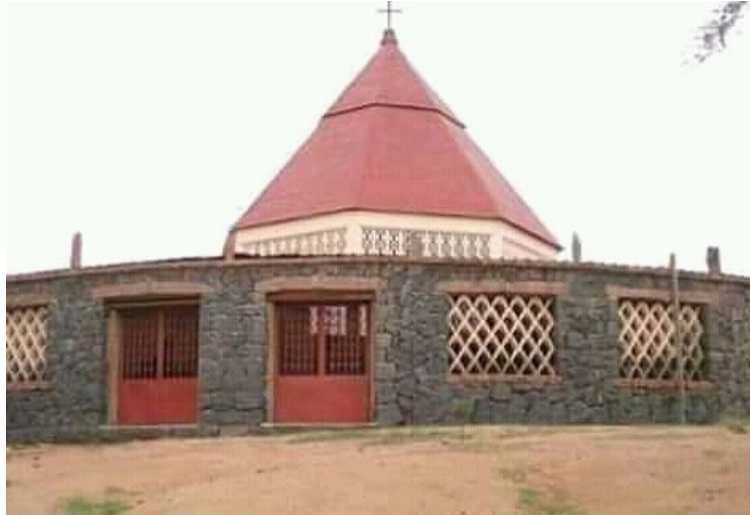
Eglise de Mangerdla avant l'incendie
